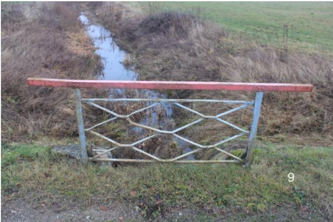
Vydutaičių tilto metalinė tvorelė vaizdas iš Vakary pusės,
