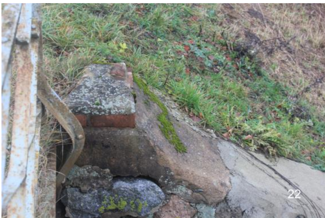
Vydutaičių tilto keturkampio plano raudonų keraminių plytų mūro stulpelių liekanos vaizdas iš Pietryčių pusės,
