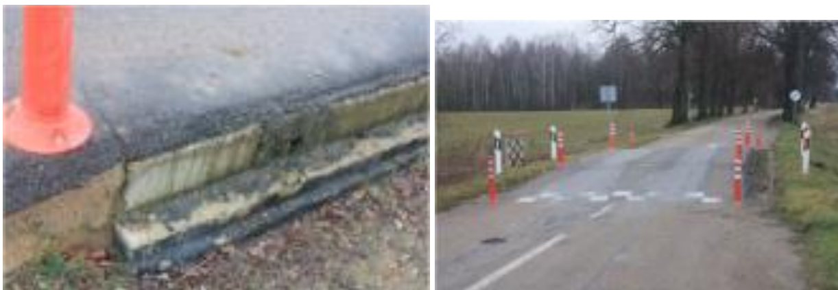
pav.3 Vydutaičių tilto sutvirtinimas įrengiant papildomą, laikiną GB bloką dangą
