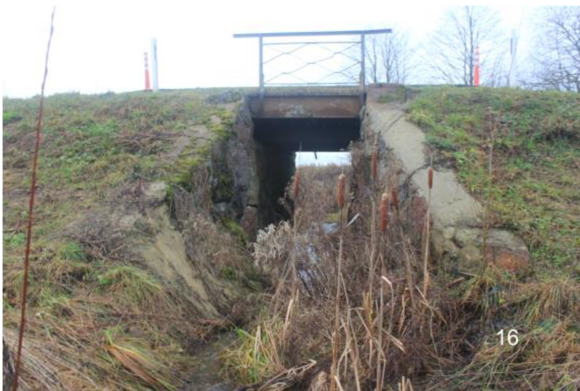
Vydutaičių tilto vaizdas iš Rytų pusės,
