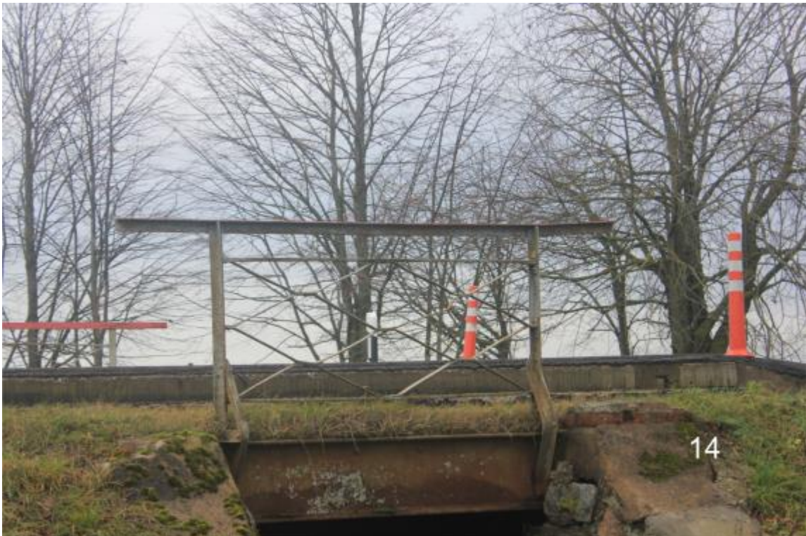
Vydutaičių tilto vaizdas iš Rytų pusės,
