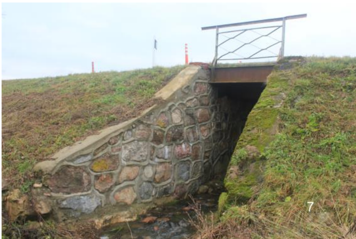
Vydutaičių tilto bendras vaizdas iš Pietvakarių pusės
