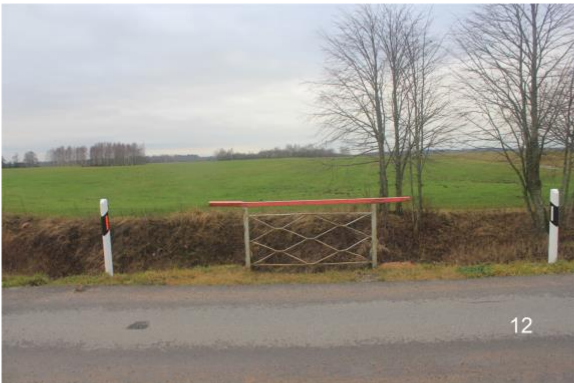
Vydutaičių tilto metalinė tvorelė vaizdas iš Rytų pusės,
