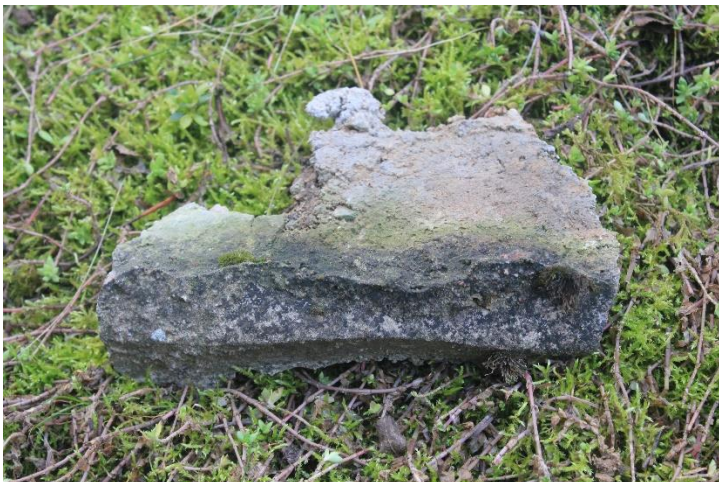
pav.6 Vydučiaių tilto (KVR u. k. 46984) akmenų mūro siūlių netektys
