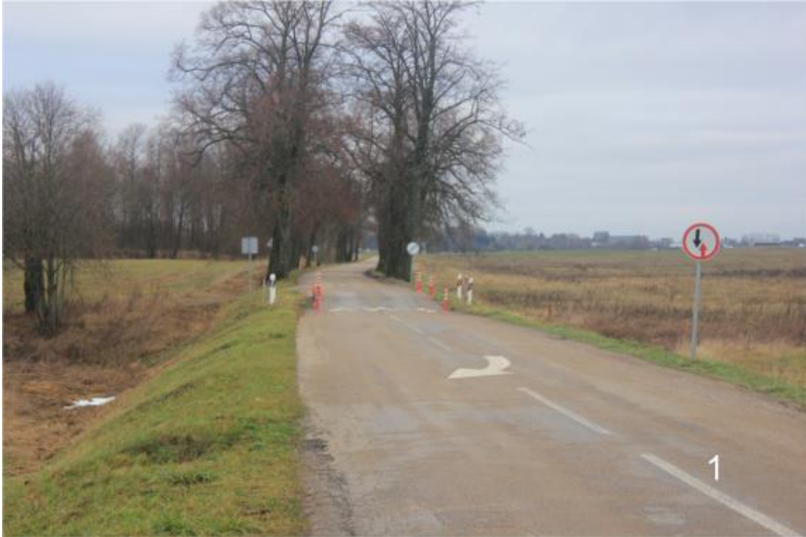
Vydutaičių tilto bendras vaizdas iš Pietų pusės
