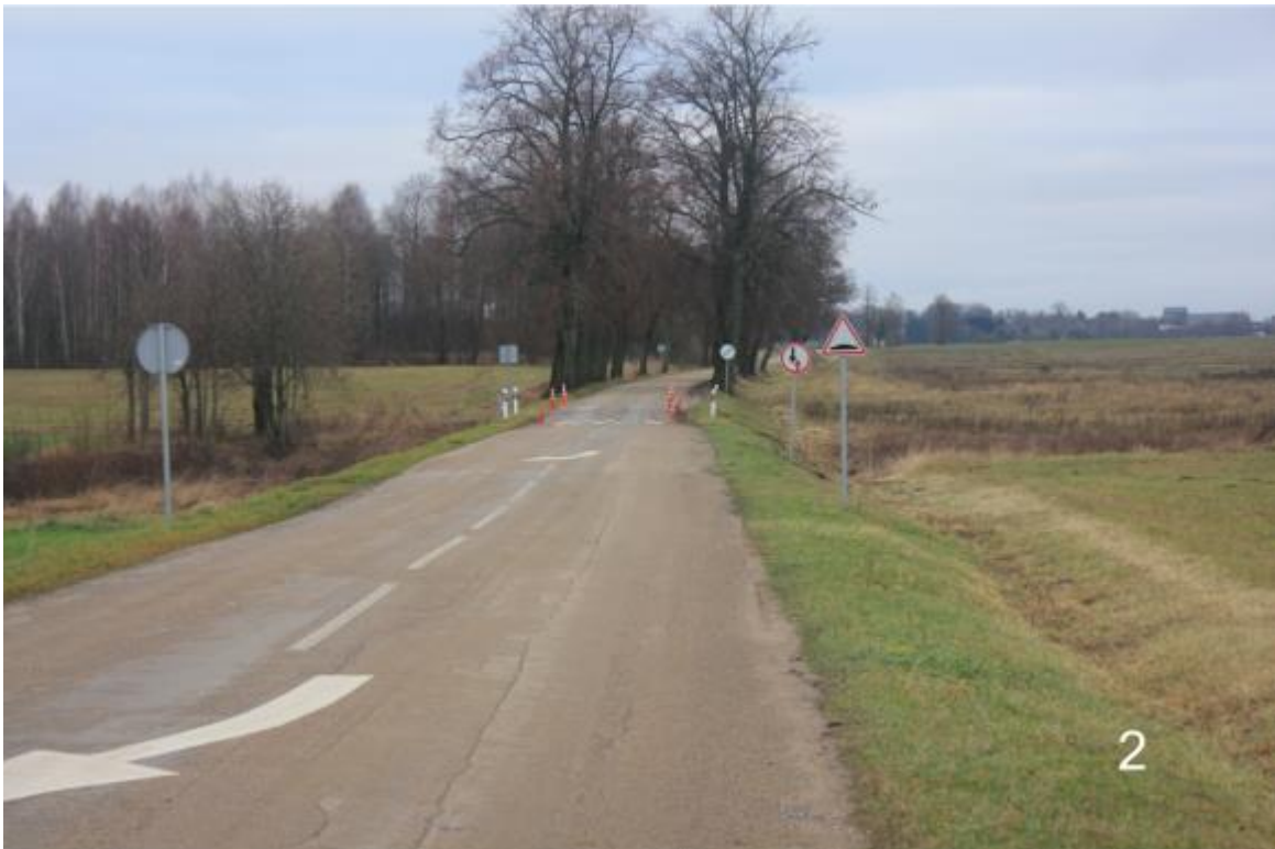
Vydutaičių tilto bendras vaizdas iš Pietų pusės
