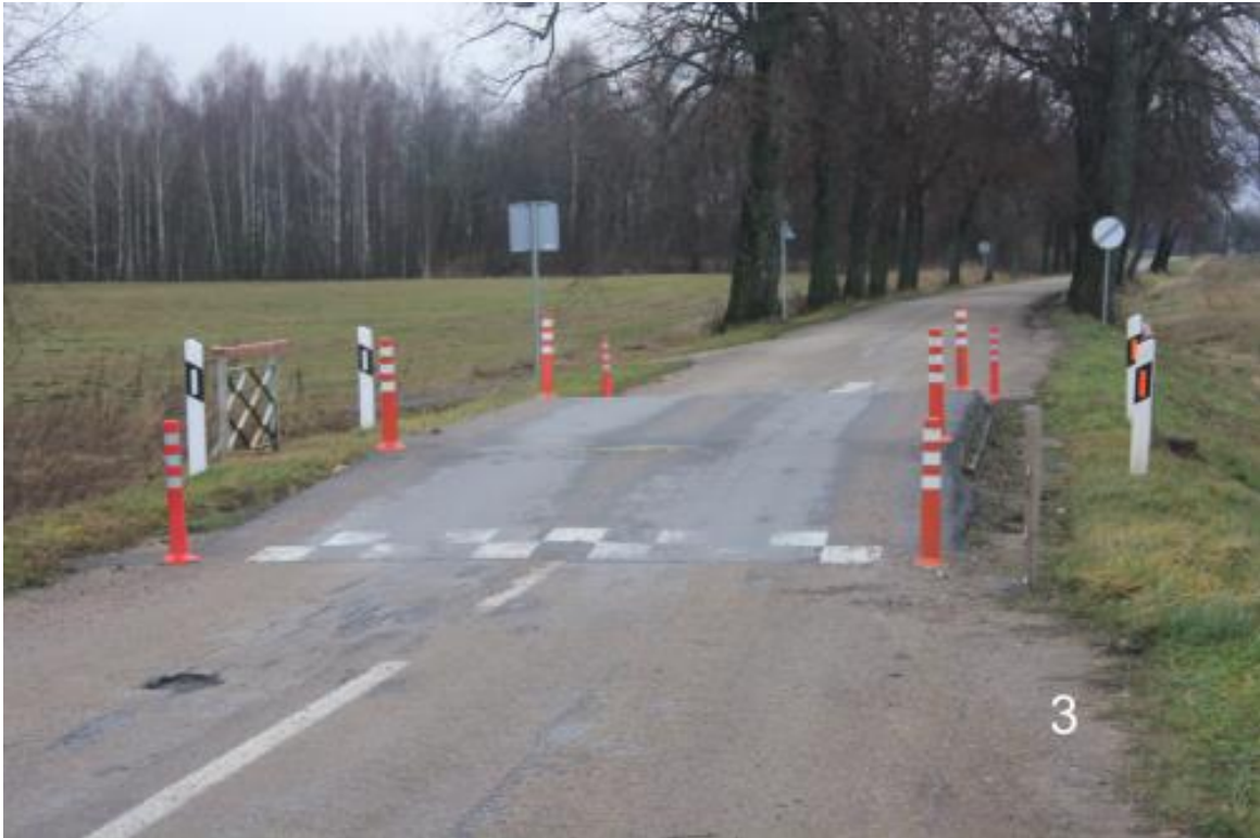
Vydutaičių tilto bendras vaizdas iš Pietų pusės
