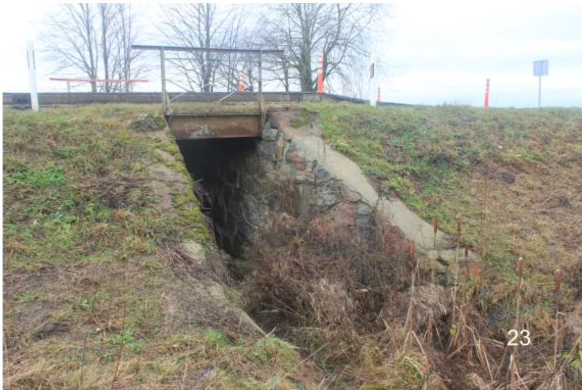
Vydutaičių tilto vaizdas iš Pietryčių pusės,
