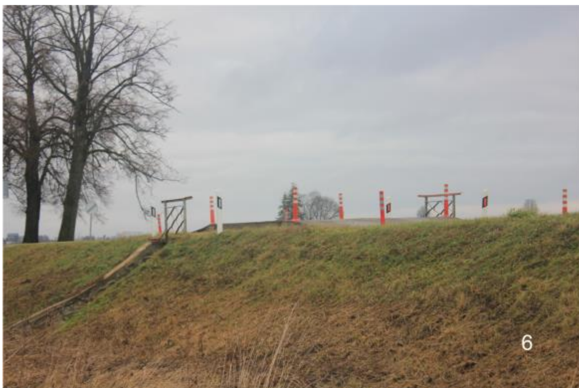
Vydutaičių tilto bendras vaizdas iš Pietvakarių pusės
