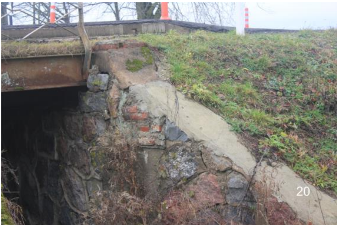
Vydutaičių tilto vaizdas iš Pietryčių pusės,
